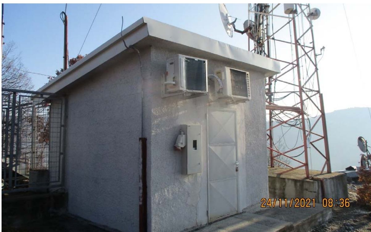
Slika 4: Objekat u kome se nalaze kabineti bazne stanice Cetin BS Prijepolje
