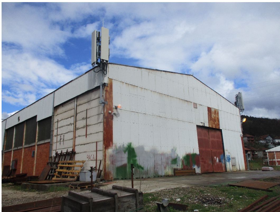
Slika 3.10 Izgled predmetne lokacije
