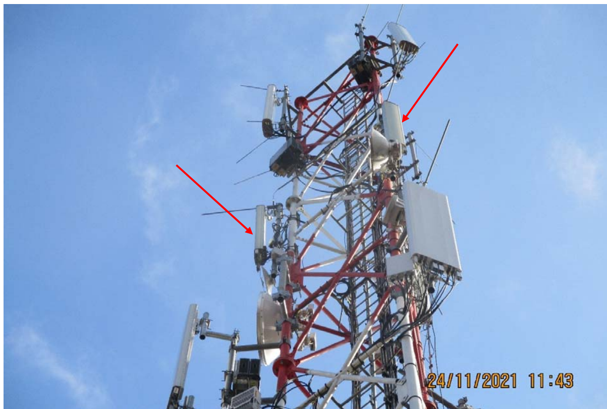
Slika 5: Prikaz antena sektora 1 i 2 bazne stanice operatora Cetin BS Prijepolje 3
