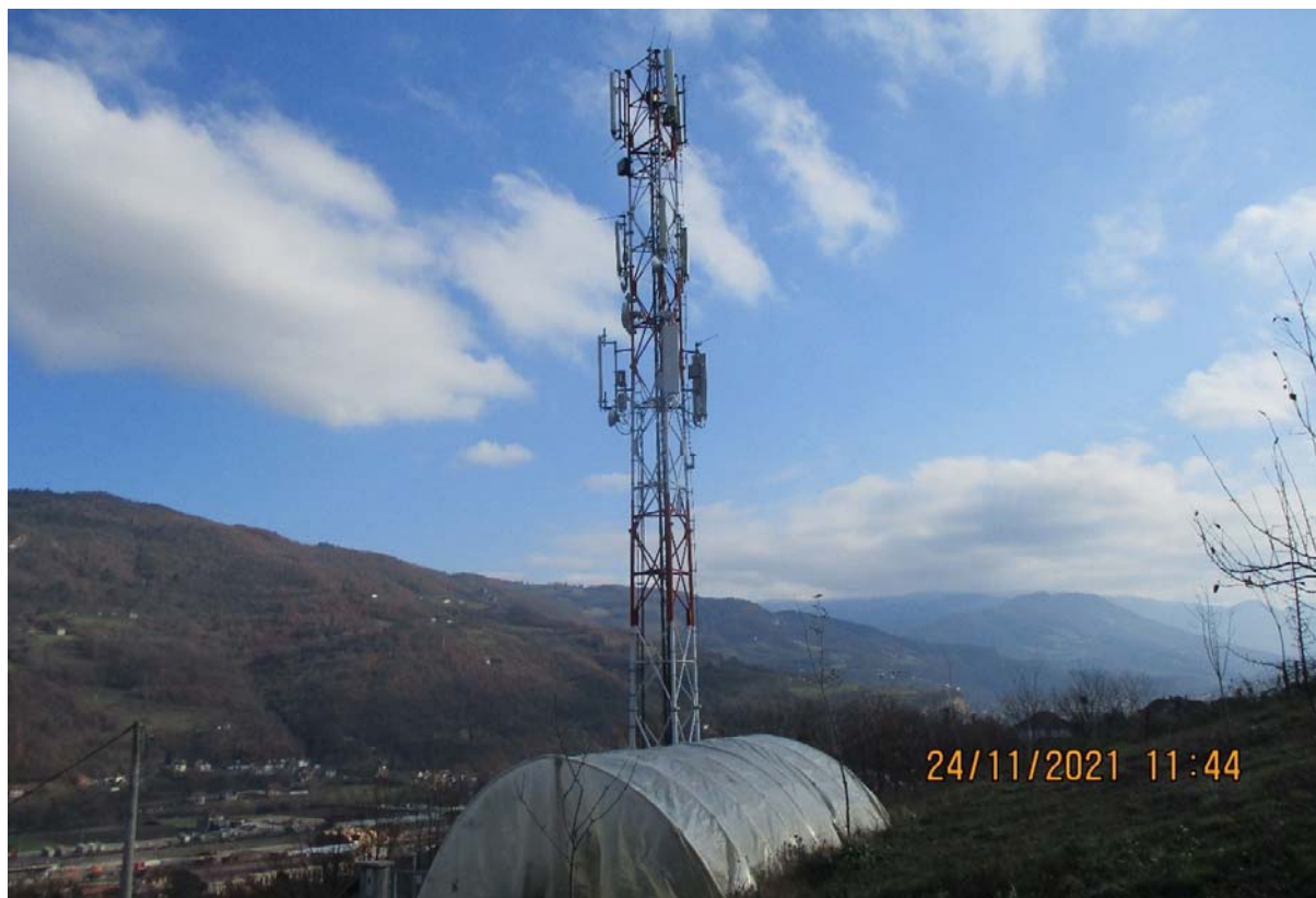
Slika 3: Prikaz stuba na kom se nalazi Cetin bazna stanica Prijepolje 3
